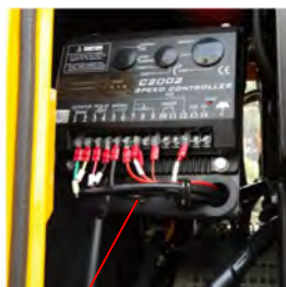
1: копче за регулиране на оборотите на двигателя
